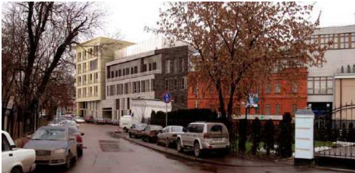
Элитный жилой дом по адресу: Москва, ул. Остоженка, 11/17
